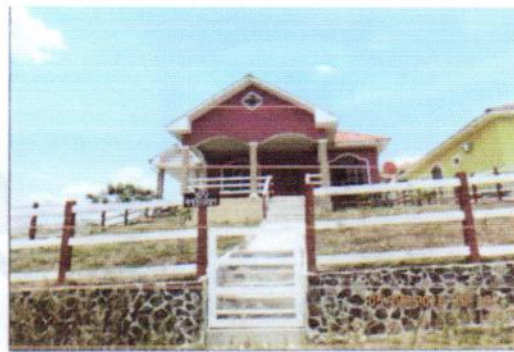
Fachada Frontal Oeste
